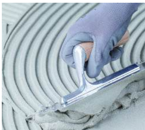
Aanbrengen van Adesilex P9 wit
