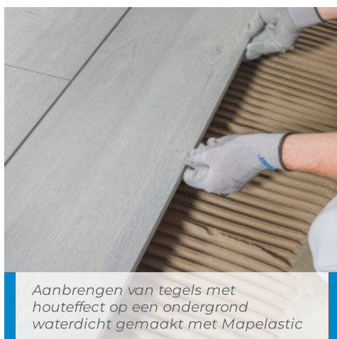
Aanbrengen van steenachtige vloertegels op bestaande vloer
